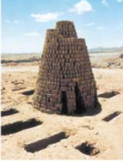
Bodenplatte des Brennofens mit Schlitzzen.
