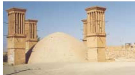
Zisterne im Zentrum von Yazd.
