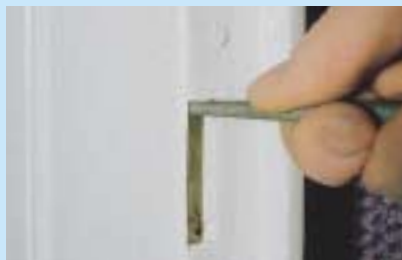
So wird der Durchlass des Schlosses vergrößert.
