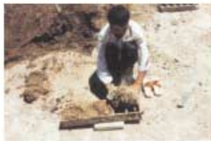
Der Lehm wird in den Backstein-Model eingefüllt.
