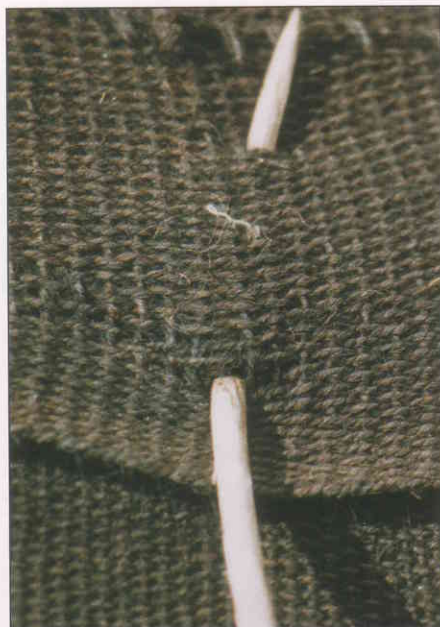
Holzdornen halten Wand und Dach zusammen.
