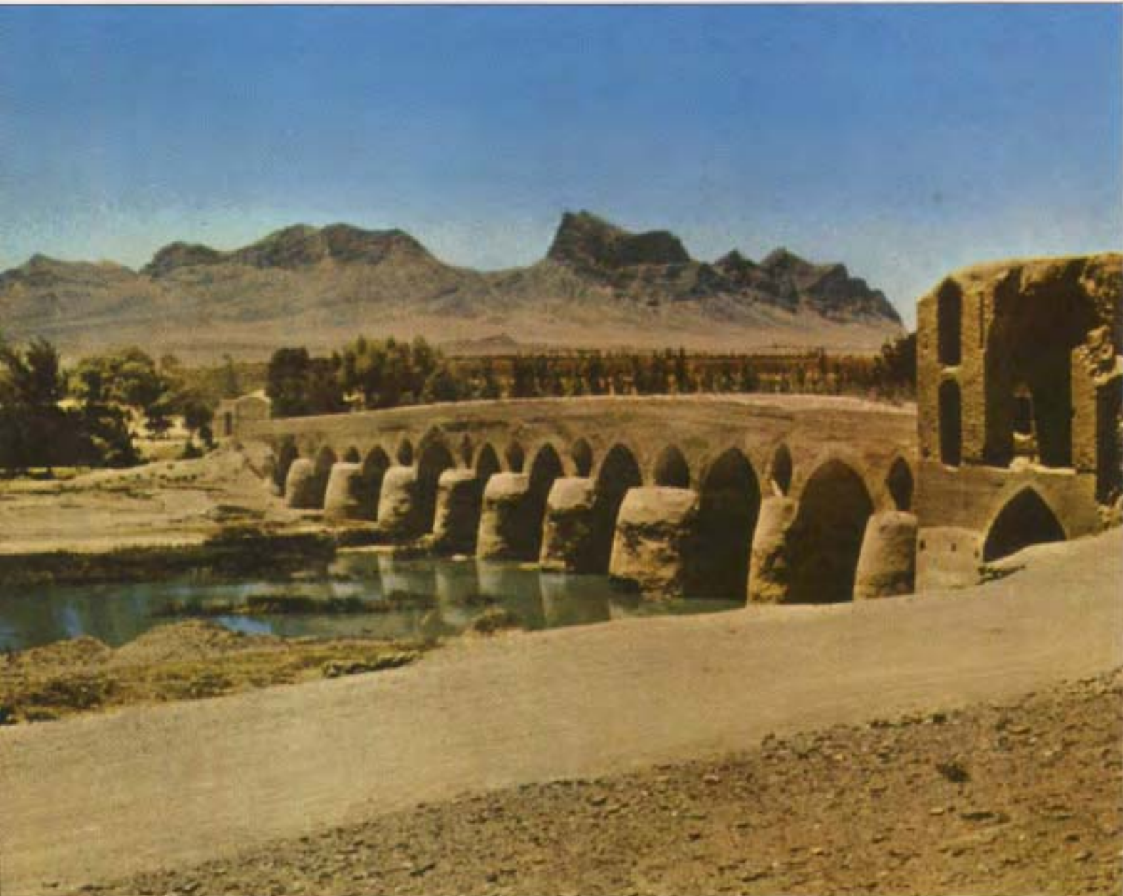
Shahristan-Brücke, Isfahan: eine der ältesten Brücken in Persien
