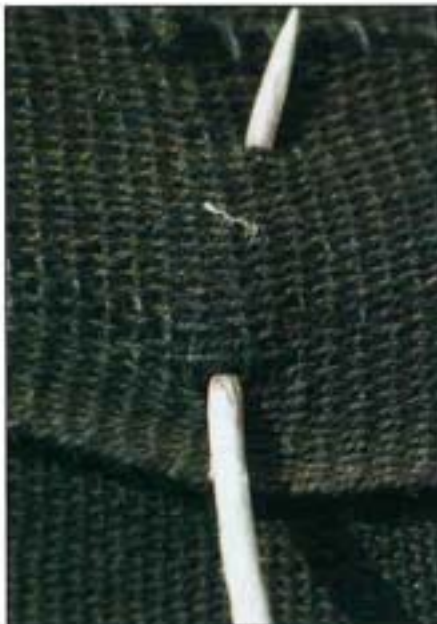
Des chevilles de bois fixent ensemble les parois et le toit
