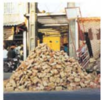
Des briques attendent leur emploi sur un chantier.
