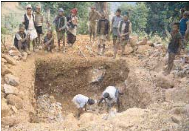
Les installations sont réalisées par les népalais .
